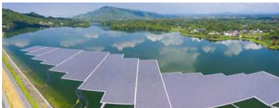
Le projet du GIE Gaves Adour consiste à installer des panneaux photovoltaïques flottants sur des lacs d'irrigation. © ILLUSTRATION GETTY IMAGES
