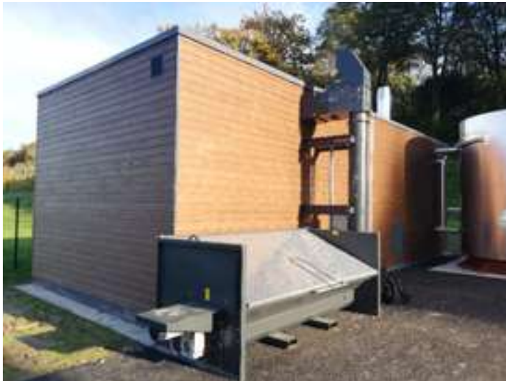
Le Sdepa a permis l'élaboration du projet de réseau de chauffage bois à Mauléon. © SDEPA
