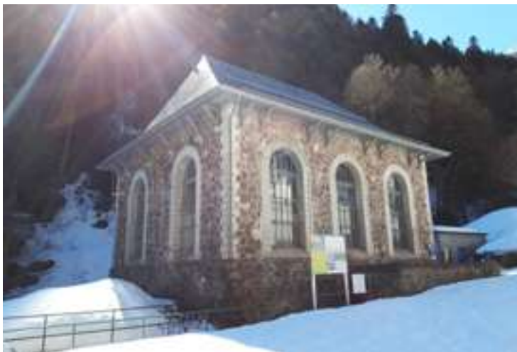
La centrale hydroélectrique EDF d'Estaëns, en vallée d'Aspe. © ARCHIVES SUD-OUEST
