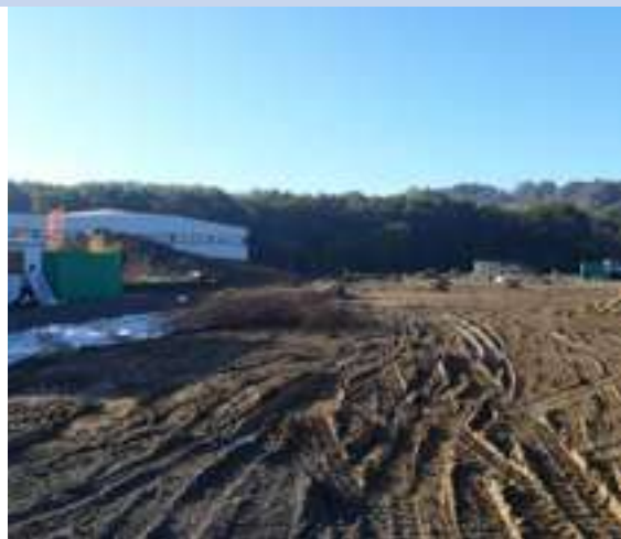
Le chantier a débuté en novembre près de l'échangeur de l'A 64 d'Orthez-Biron.
