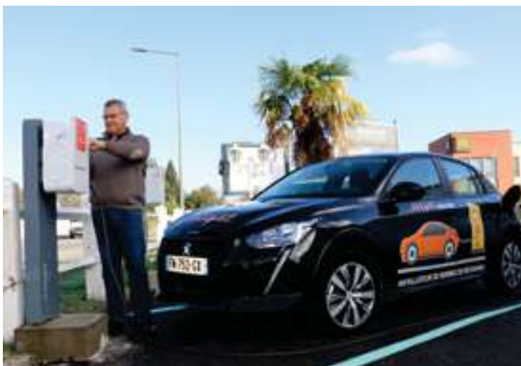
Angelo Poitou a installé les bornes de recharge du Buffalo Grill au nord de Pau. © S. SAVARIAUD
